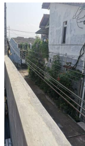
Gambar 7 Rute kabel dalam kenyataan
